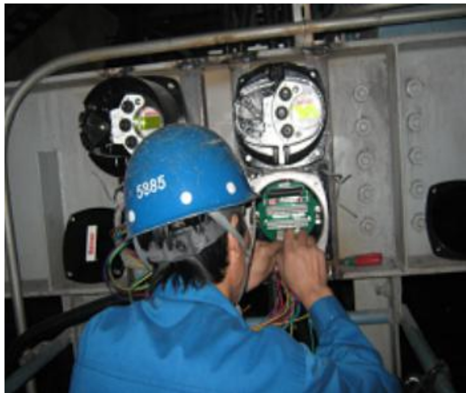
Раздельный монтаж привода и блока управления
